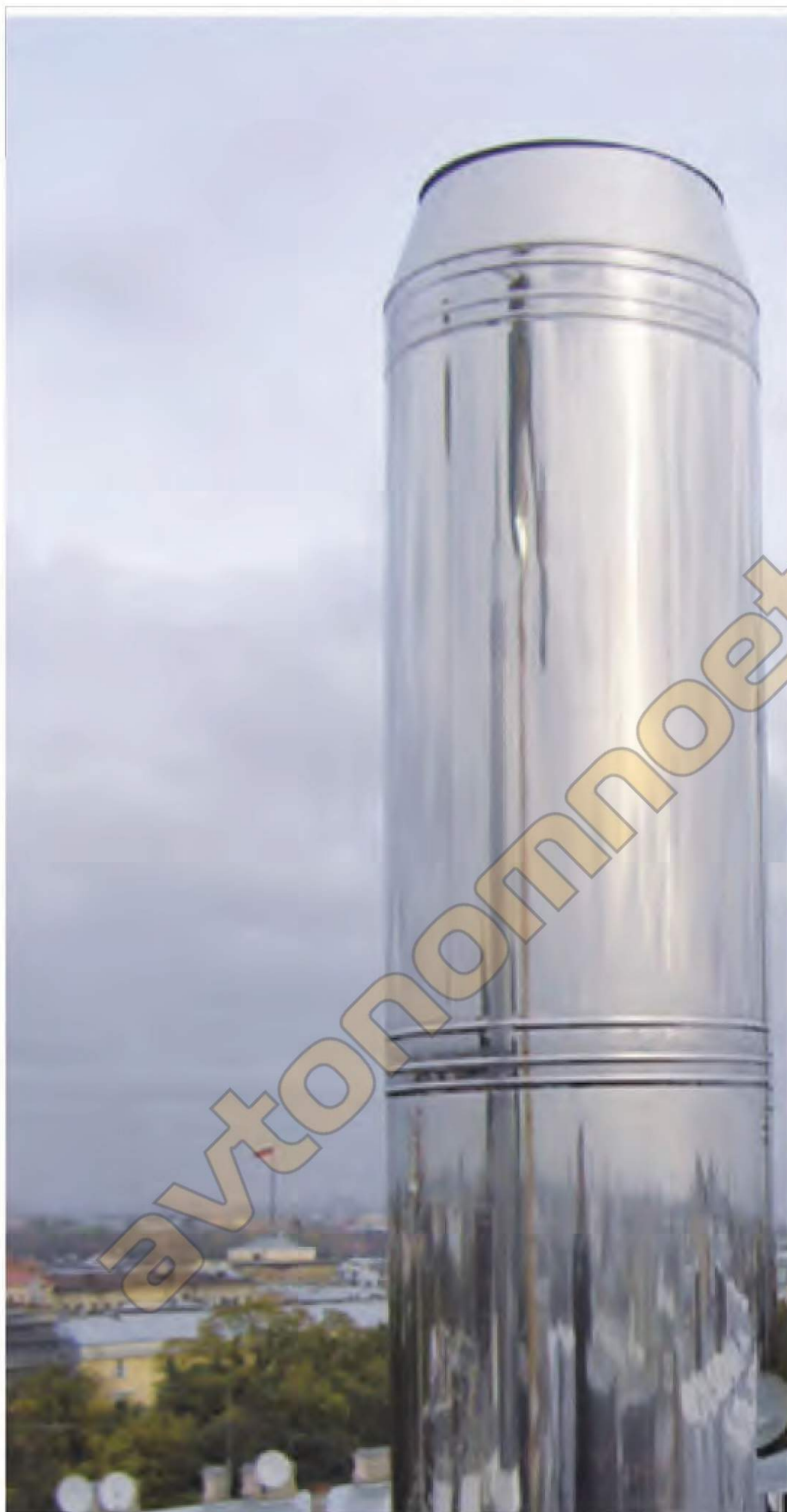
Арка Генерального штаба Два дымохода трубы \varnothing 500/600
