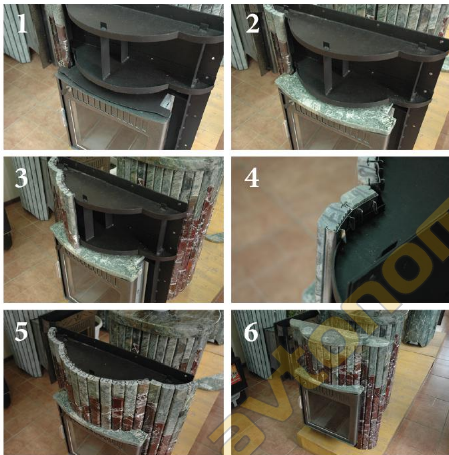
Рисунок 8.4.1. Схема установки ламелей и столешниц на портал печи.
