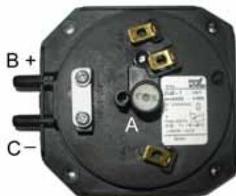
„A“ - винт регулирования давления
