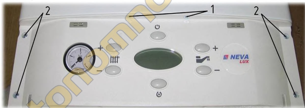
Рис. 16. Демонтаж облицовки и передней панели
