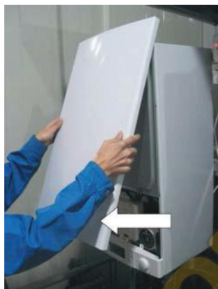
4. Поднимите вверх и снимите переднюю панель.
