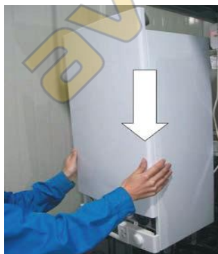
7. После проверки работоспособности устройства установите переднюю панель и сдвиньте ее вниз.
