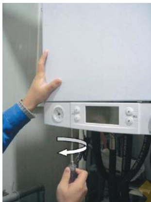
2. Открутите два винта в нижней части передней панели.
