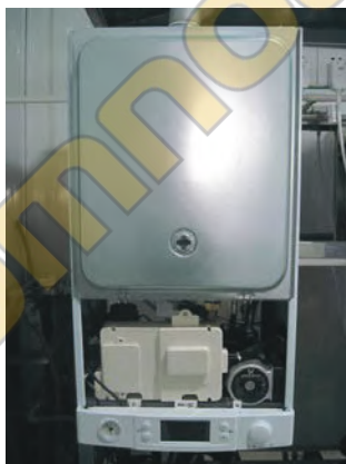
5. Снимите переднюю панель..
