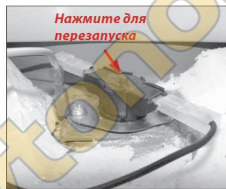
Рис.9 а Перезапуск котла в случае перегрева
