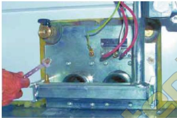
рис. 23 - Демонтаж горелок
