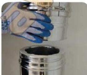
**1.** Разомкнуть обжимной хомут вышерасположенного элемента и слегка сдвинуть вверх.
