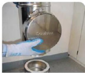
**1.** Установить тройник на основание с отводом конденсата или напольную опору с отводом конденсата.
