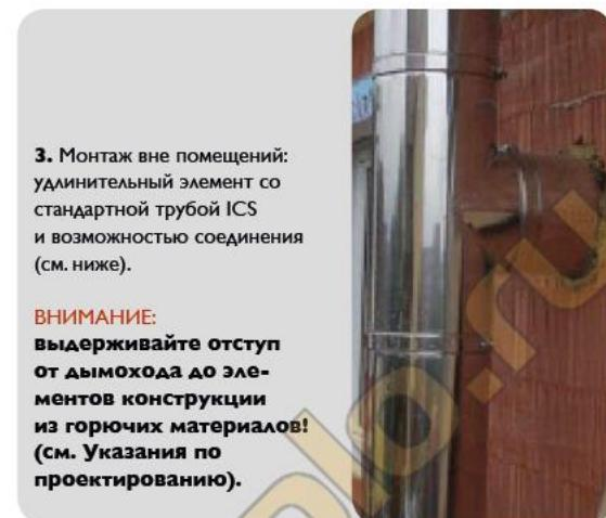
**3.** Монтаж вне помещений: удлинительный элемент со стандартной трубой ICS и возможностью соединения (см. ниже).
