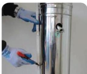
1. Укоротить нижний элемент до нужной длины с помощью отрезной машины, вставить в опорную плиту.
