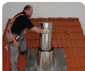
**3.** Установить линейный элемент трубы по стандартной схеме монтажа. Проход через крышу выровнять относительно дымохода.
