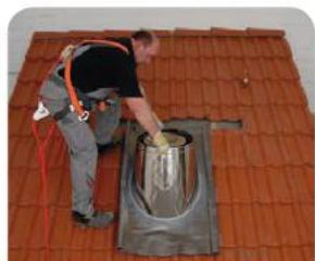
**2.** Проход через крышу установить с учётом рекомендаций производителя кровельных конструкций.
