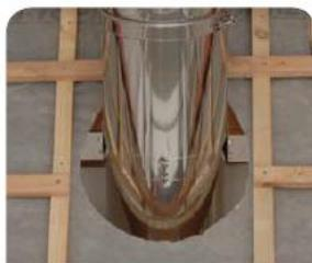
**1.** Диаметр проёма в крыше должен быть сделан с учётом противопожарной разделки (соблюдайте отступ от элементов конструкции из горючих материалов)
