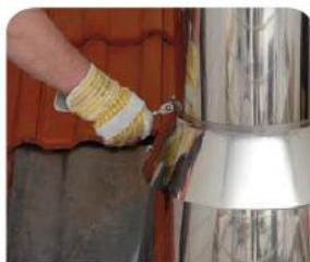
**5.** Манжету от дождя установить на элемент трубы поверх проходного элемента, жёстко зафиксировать. Далее собрать все оставшиеся элементы, включая последнюю трубу.
