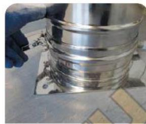
**3.** Затем, соединить два элемента труб с помощью обжимного хомута.
