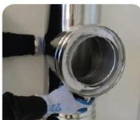
**1.** Установить тройник 90°/ 85°/ 45°. Соединить с нижерасположенным элементом обжимным хомутом.
