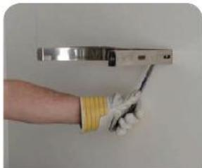
2. Разметить и выполнить отверстия. Отверстия должны быть выровнены по горизонтали. Монтаж осуществляется только на несущую стену, которая сможет выдержать нагрузку от дымохода.
