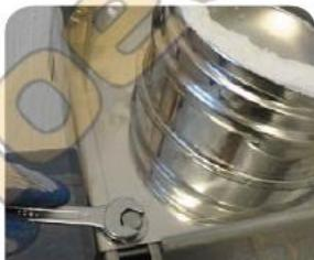
**6.** Настенный элемент с отводом конденсата соединить с опорной консолью. Дальнейший ход монтажа описан на стр. 12 (трайник прочистки).
