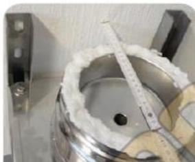
**5.** Определить расстояние между дымоходом и стеной.
