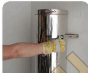
3. Установить элементы дымохода и соединить их с настенным хомутом. Жёстко зафиксировать дымоход с хомутом.
