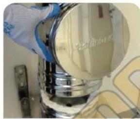
**1.** Установить тройник на настенный элемент с отводом конденсата.
