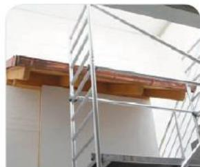
1. Перед началом монтажных работ установить строительные «леса», принять меры по обеспечению безопасности работ.
