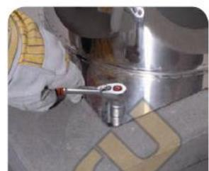
2. Закрепить основание с отводом конденсата на фундаменте (фундамент подготавливается заказчиком). Дальнейший ход монтажа описан на стр. 13 (тройник прочистки).
