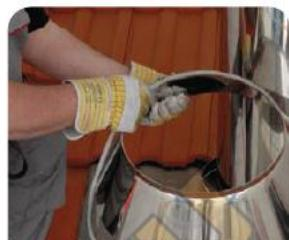
**4.** Монтаж манжеты от дождя: выполнить гидроизоляцию с помощью герметика или специальной клейкой негорючей ленты.
