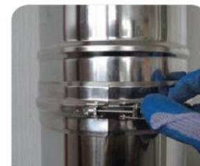
**3.** Установить элемент трубы. Соединить с последующим элементом с помощью обжимного хомута.
