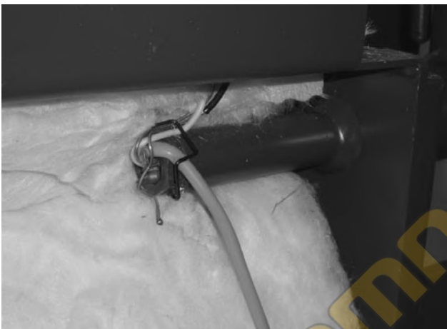
Рис. 15 – датчик температуры воды TV, установленный в отверстии котла DCxxSP(EP) или котла с горелкой в верхних дверцах DCxxS(X), CxxS, ACxxS, DCxxRS
