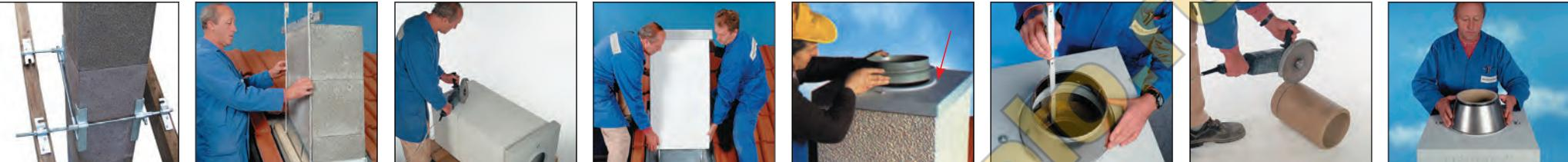
41. При необходимости используйте комплект креплений к конструкции крыши для оформления верхней части дымовой трубы снимите все необходимые размеры в соответствии с на- клоном крыши.
