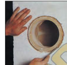
29. Установите переднюю панель из минеральной ваты между керамическим тройником и каменной оболочкой. Уменьшите высоту передней панели при помощи пилки.
