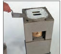
5. Блок установите на раствор марки М150 на подготовленном цоколе. Выровняйте при помощи уровня. Для удобства эксплуатации разместите отверстие для подачи воздуха, а также дверцы для очистки дымохода под углом 90° к оси подключаемого потребителя. Установите ёмкость для сбора и отвода конденсата в центре блока на цементный раствор.
