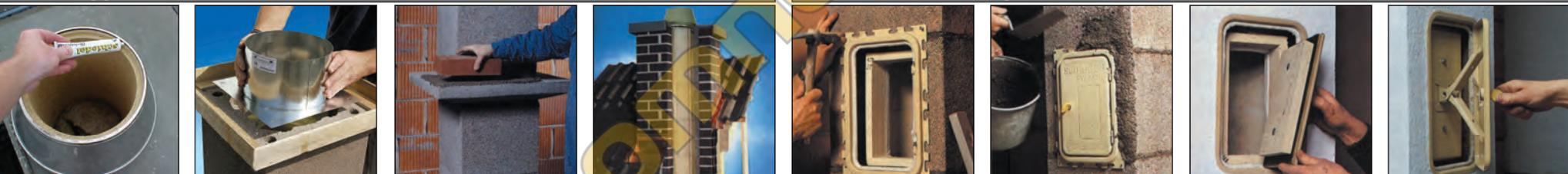
49. Шов между внутренней ке- ракомической трубой и конусом уплотните специальным сили- кононым герметиком Hermesil.
