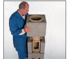
13. Перед началом монтажа всегда очищайте оба конца керамической трубы. Нанесите герметик или массу для заделки швов на нижнюю поверхность керамического тройника для подключения дверцы. **Работы с герметиком вести только при температурах выше 5°C.**
