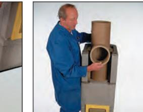
25. Установите каменную оболочку на подготовленный цементный раствор. Монтируйте дымоход индивидуально, не связывайте его с окружающей кладкой. Правило действует как для стен, так и для перегородок.
