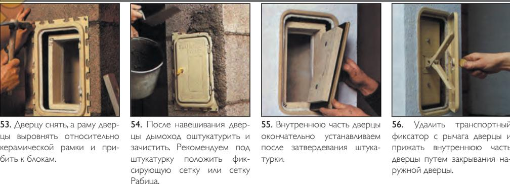
53. Дверцу снять, а раму двер- цы выровнять относительно керамической рамки и при- бить к блокам.
