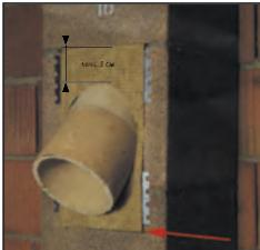
21. Изоляционные плиты согните, как показано на рисунке. Место соединения двух изоляционных элементов должно располагаться посередине одной из сторон каменной оболочки.
